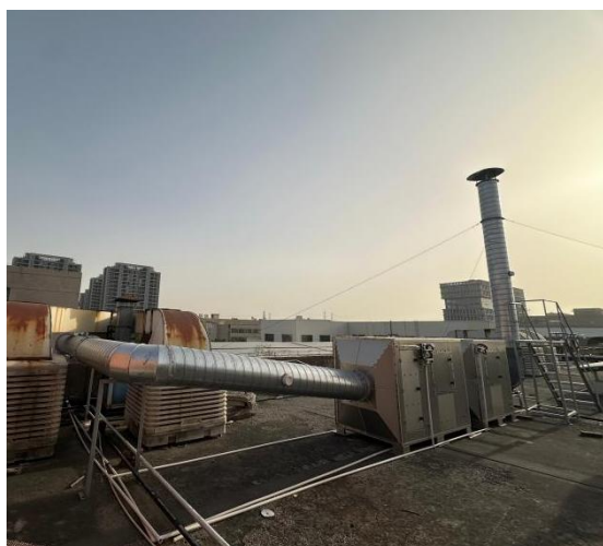
废气处理设施及排气筒
