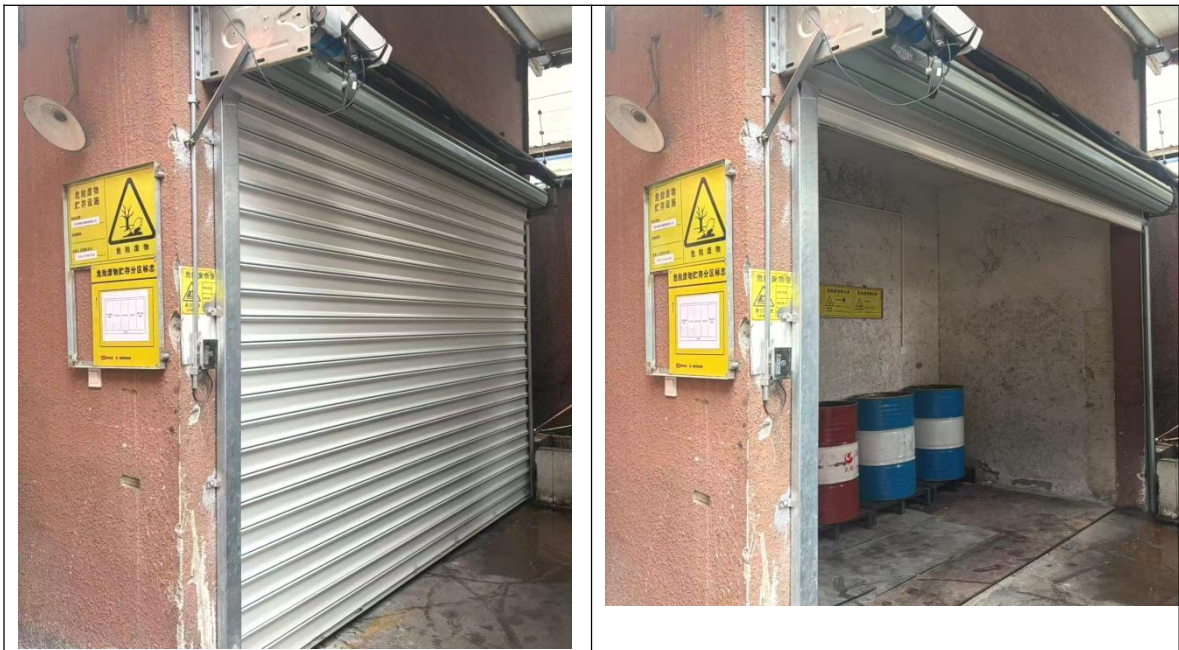
危险废物暂存场所
